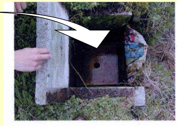
排水調整板設置状況
