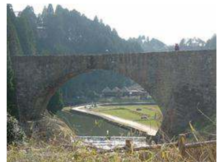
逆サイホンを利用した水路橋で国の重要文化財にも指定されている通潤橋 (熊本県山都町)
