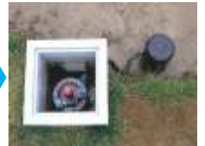
給水栓の自動化へ改良
