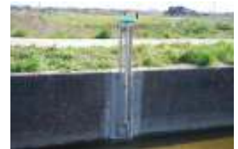
巻き上げ式ゲート（分水用ゲート）
