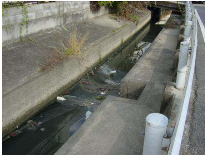
非かんがい期で通水が停止し、雨水のみが滞留して水質が悪化した農業用水路（周辺は新興住宅地）
